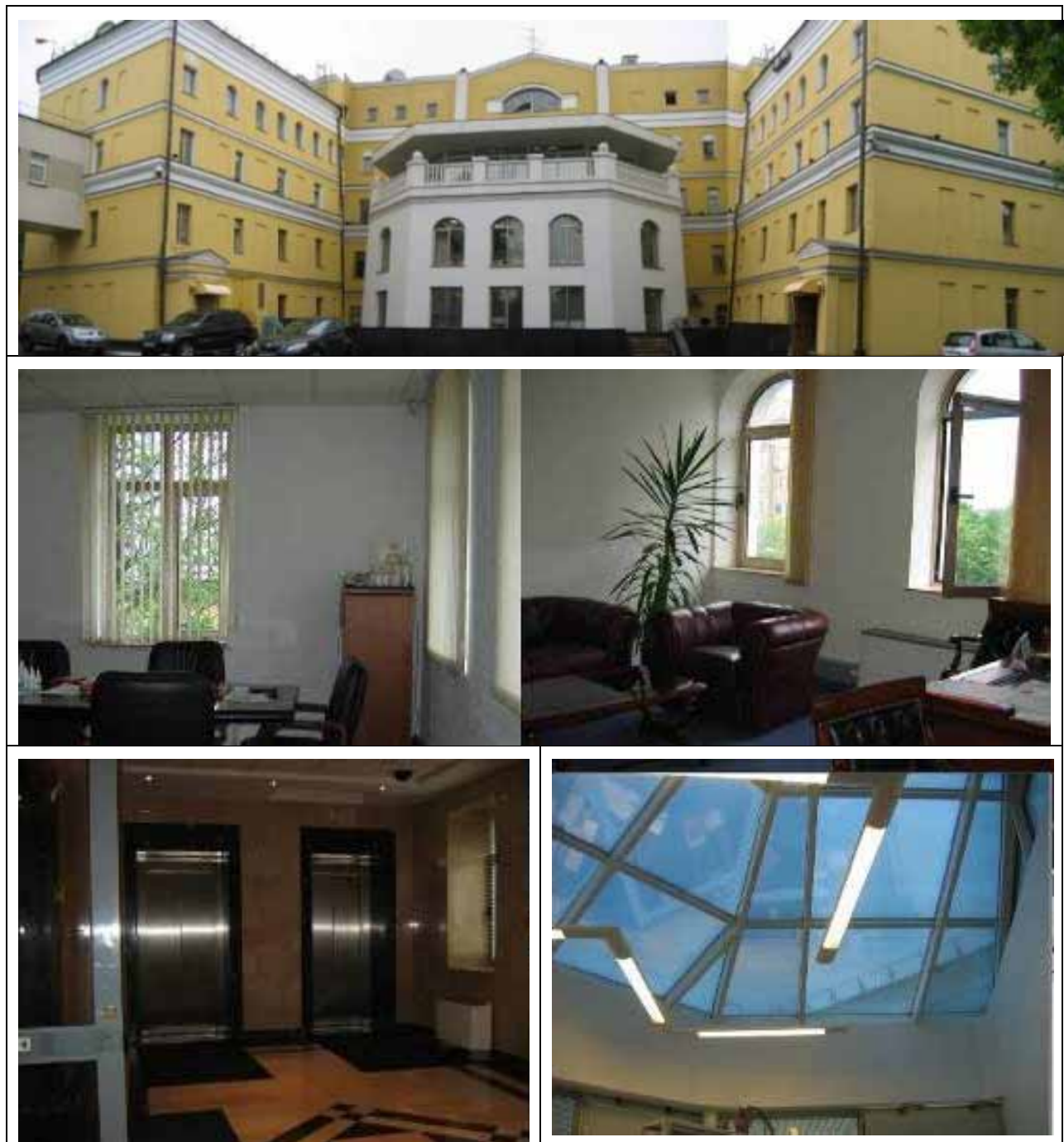
Рис. 15.2 Внешний вид здания ул. Погодинская, д.24, стр.1
